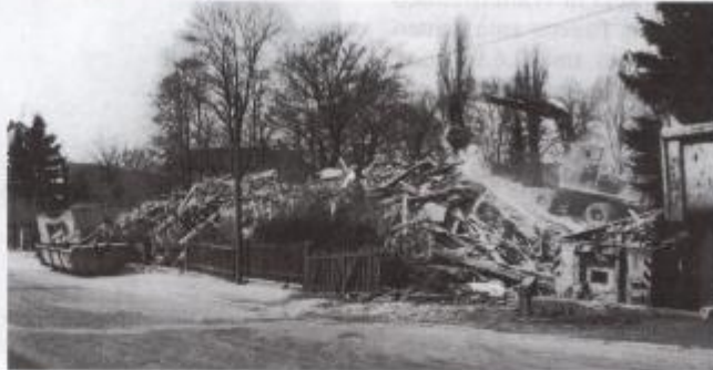
vom alten Krankenhaus übriggeblieben - ein Trümmerberg aus Balken und Steinen (25.4.1996)
