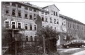
Vorderansicht '96 mit Brandschäden am Dach
