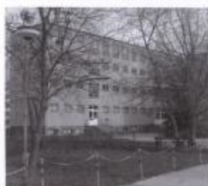
Die Grundschule in Ibenhain soll modernisiert werden.
