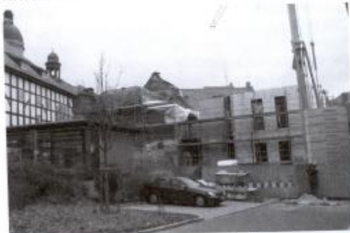
Die Bauarbeiten für die neue Bibliothek gehen voran.
